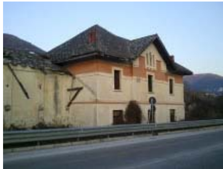
Ex-stazione di Pizzoli, in stato di abbandono
