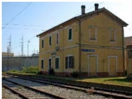
Ex-stazione di S. Vito Trasbordo, in discreto stato di conservazione
