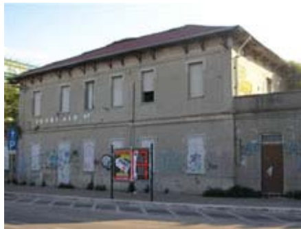
Ex-stazione di Pescara Porto, in stato di abbandono
