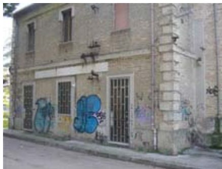
Ex-stazione di Montesilvano Spiaggia, lato binari
