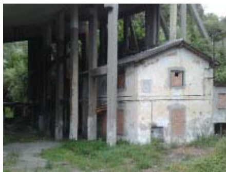
Ex-casello allo sbocco della galleria Valloria, murato e abbandonato
