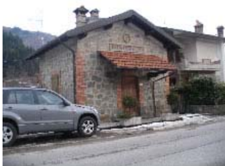
Ex-stazione di Pontepetri, in ottimo stato di conservazione
