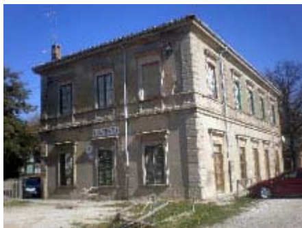
Ex-stazione di Volterra, in discreto stato di conservazione
