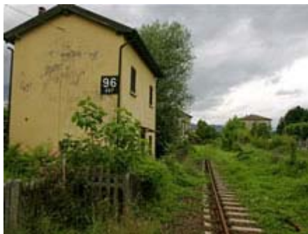
Ex-casello alla progressiva 96,997
