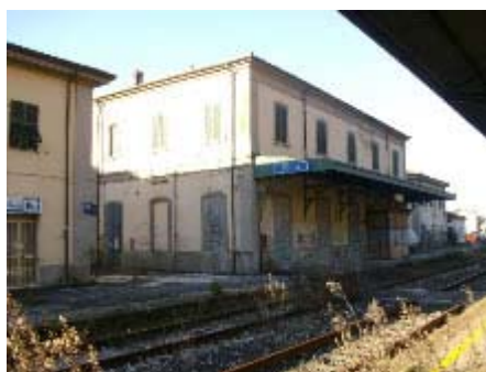
Fabbricato viaggiatori della ex-stazione di Aulla, abbandonato e con gli ingressi murati
